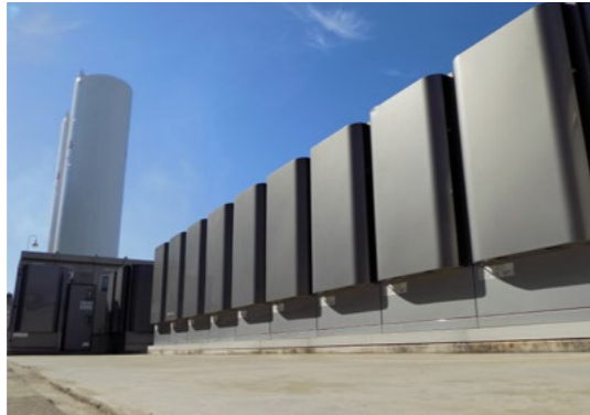
固体酸化物燃料電池 (福井事業所)
